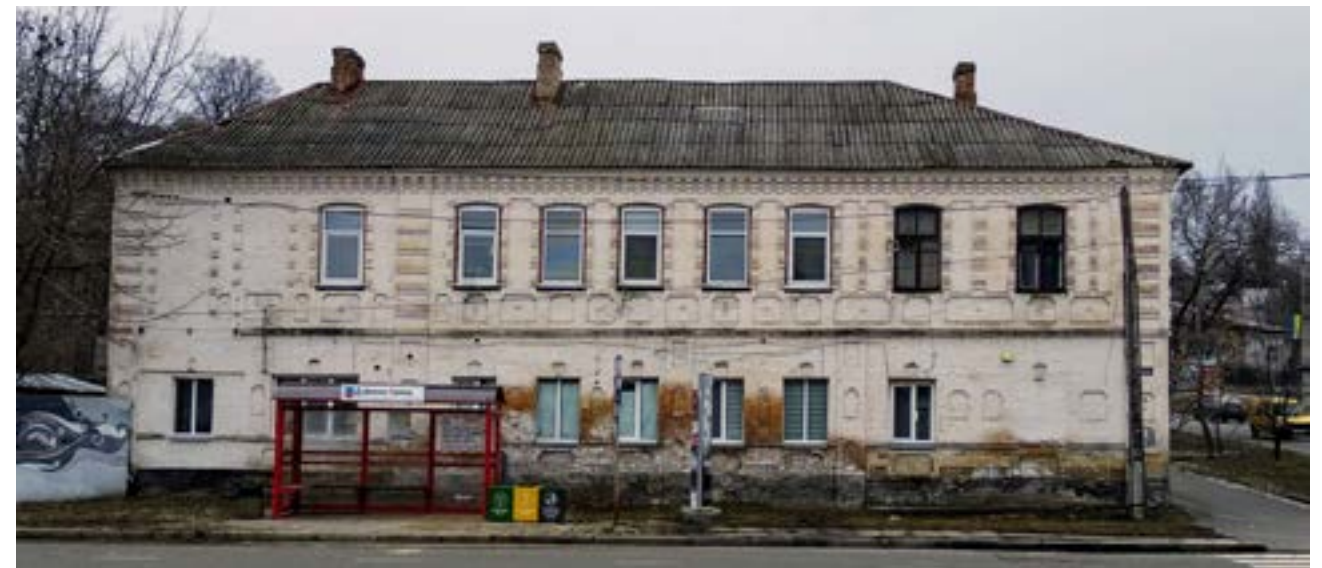
1. Будинок купця Куперштейна на розі вулиць Гагаріна – Замковий узвіз. м. Черкаси. Фото 2019 р.
